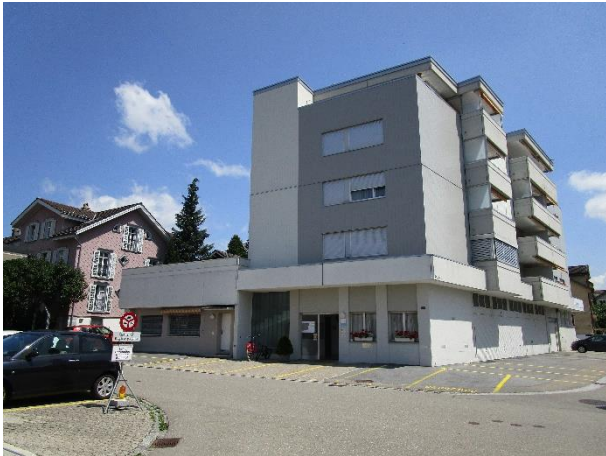
Abbildung 20: Neugasse 6: Neubau von 1974
