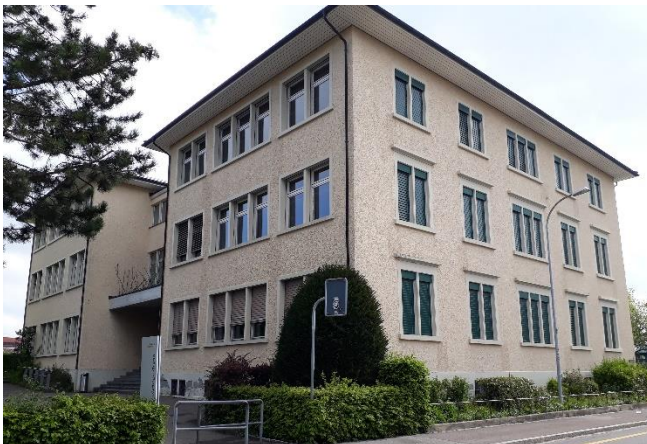
Abbildung 21 D: Schulhaus Vorderer Grund
