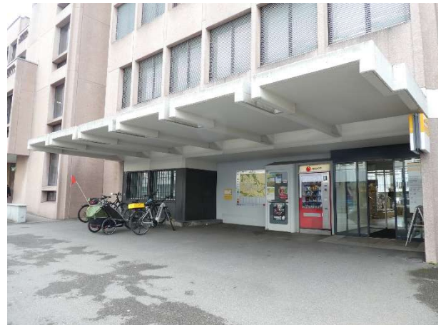
gedeckter Eingang ab Bahnhofstrasse
