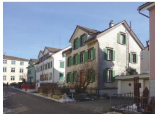
Einfaches Haus in ortstypischer 2 1/2 geschosiger Bauweise mit kleinem Vorgarten. Quadratische Gebäudegrundfläche mit den Abmessungen 8.5/ 8.5 m. Das Haus ist Teil einer weitgehend intakten Häuserzeile mit Orientierung der Hauptfassade nach Westen. Im Erdgeschoss befindet sich ein ehemaliges Sticklokal mit direktem Zugang von der Strasse. Ein Autoabstellplatz ist südseitig angebaut.
